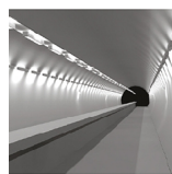
Etudes lumineuses pour tunnels
